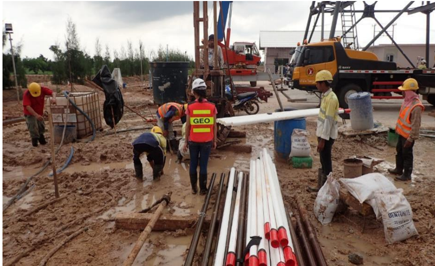
รูปที่ 3.7.2-4 การขุดเจาะและติดตั้งท่อวางในแนวตั้งสำหรับวัดการเคลื่อนตัวของมวลดินในแนวราบ
